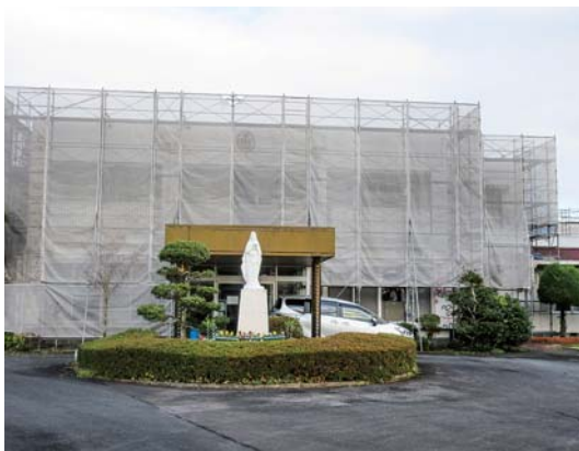
ただいま外壁工事中
